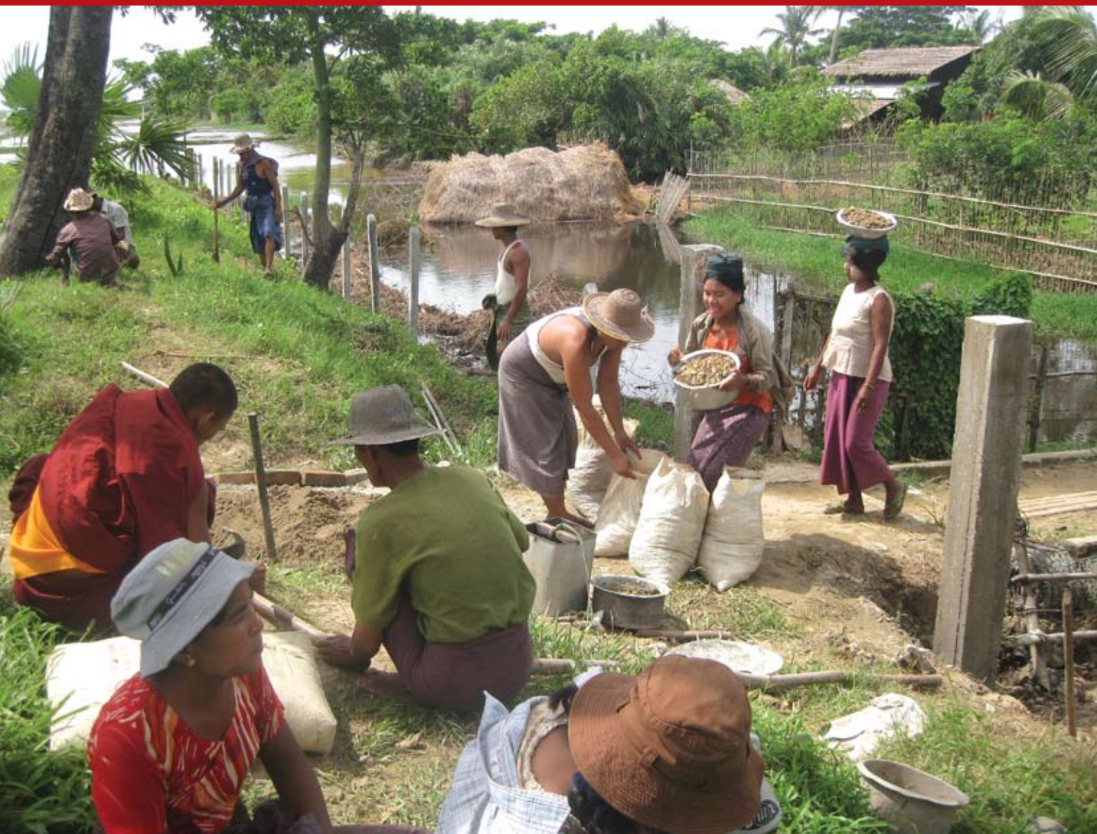
Oprava rezervoáru na pitnou vodu, Myanmar. Foto: KARUNA, partnerská organizace Charity ČR
